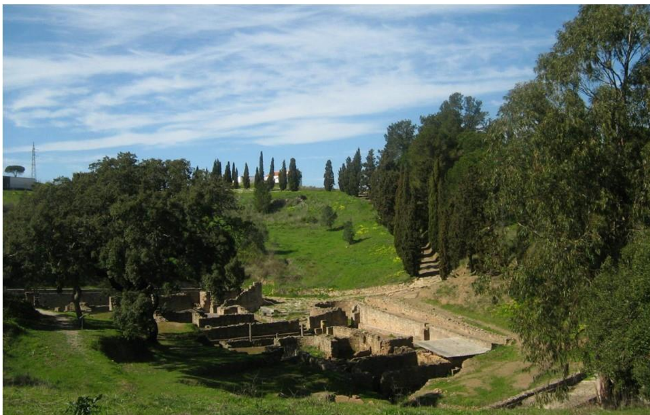
Fig. 9: Vista geral dos Balneários de Miróbriga
